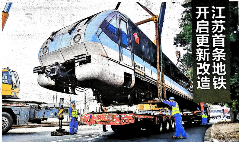
10月16日,南京地铁马群车辆基地,随着地铁1号线0304列车第一节车厢被起吊搬运,作为江苏首条地铁,运营20年的南京地铁1号线开启5年左右的更新改造工程。1号线67辆列车将分批运回中车南京浦镇车辆厂进行车载信号、电气设备等关键部位的更新。 李昌华 张筠 王诗宇 摄
